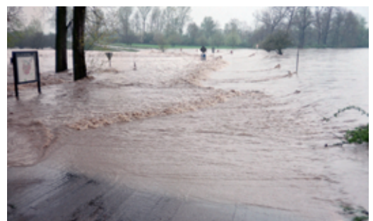
Hochwasser April 1994, überflutete Straße zwischen Altnecker und Neckarkanal
