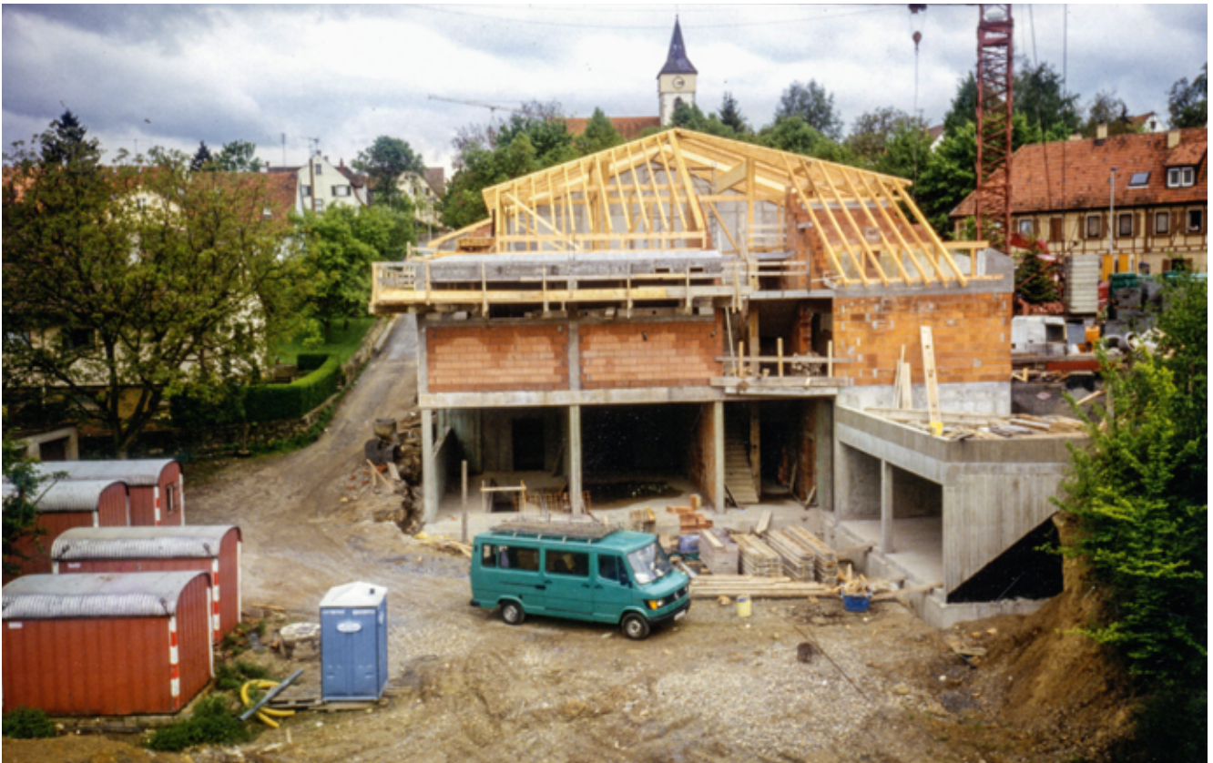
Baustelle des Feuerwehrhauses aus Sicht vom Gründelbach
