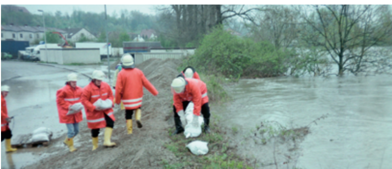
Hochwasser April 1994, Sicherungsarbeiten am Hochwasserdamm in der Marbacher Straße
