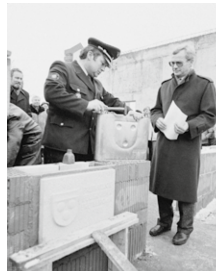
Kommandant Karl Rendle jun. und Bürgermeister Herbert Schlagenhaut bei der Grundsteinlegung
