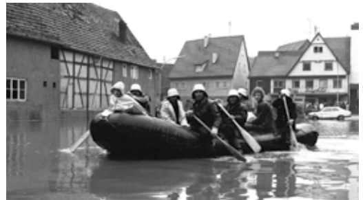
Hochwasser 1978, Transport mit dem Schlauchboot in der Benninger Straße
