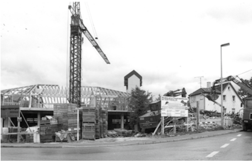
Baukran am Feuerwehrhaus aus Sicht vom „Pflaster“
